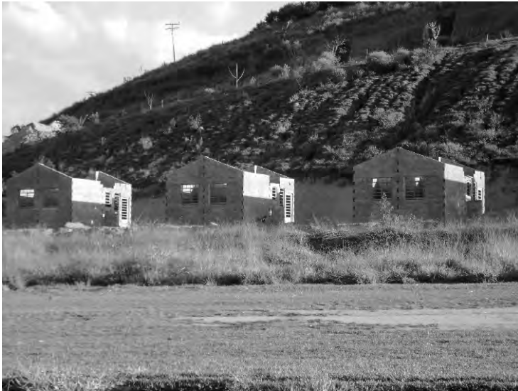
Algumas casas em fase de construção
