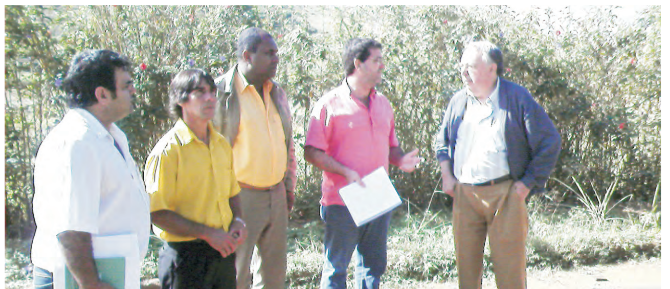
Juntamente com o Secretário de Planejamento, Francisco Nascimento, os vereadores foram verificar o estado do anel viário
